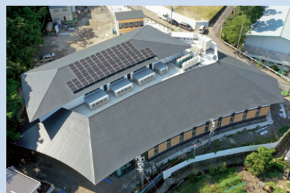
安田町役場新庁舎
